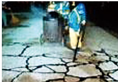
道路用クラック補修材 東洋アスファルトG™ 東洋道路興業(株)との共同研究 平成15年(2003)
