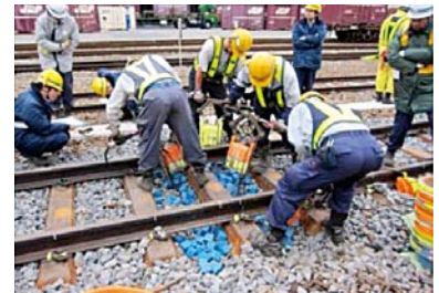
鉄道軌道安定化のための、有機繊維強化 コンクリート構造体および安定化工法の開発 (JSTニーズ応応型研究) 実試験推進中 モモコ・CUBE™ 東洋道路興業(株)との共同研究 平成22年(2010)
