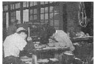
井波分室作業室
