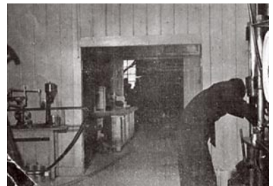
金属試験機械室
