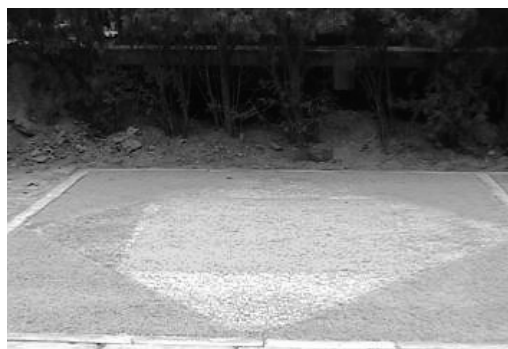
図1 施工後、着色した試験施工地
