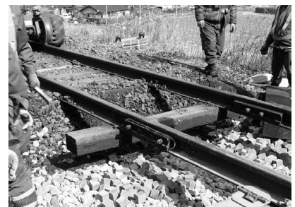
図4 実軌道での保線作業
