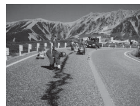
アスファルト補修材 T-Dプライマー 東洋道路興業(株)との共同研究 平成11年(1999)
