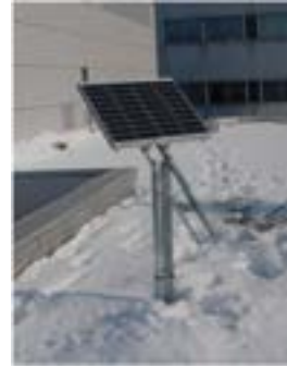
(b)屋上に設置した太陽電池モジュール(43W)
