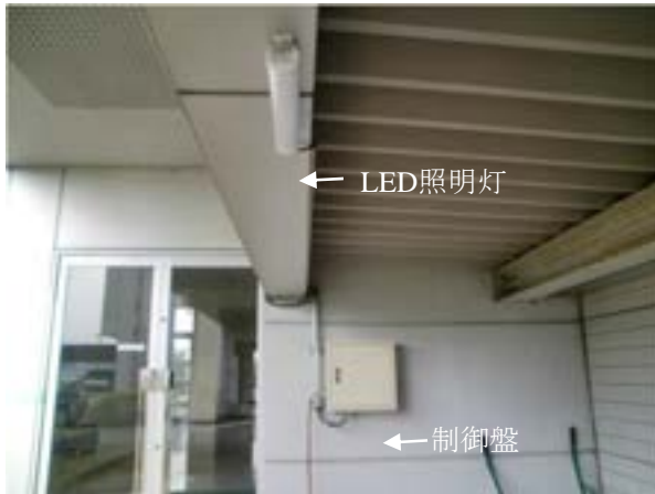
(a)LED照明灯の設置状況 (自転車置場)
