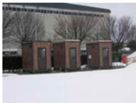
冬の屋上緑化実証試験の状態 (左:ユニットハウス、中:耐雪型緑化パネル設置、 右:融雪型耐雪型緑化パネル設置)
