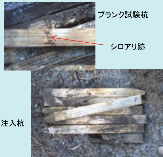
図2 ブランク杭のシロアリ跡と防蟻処理した注入試験杭
