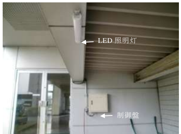
図 2 LED 照明灯の設置状況 (自転車置場)
