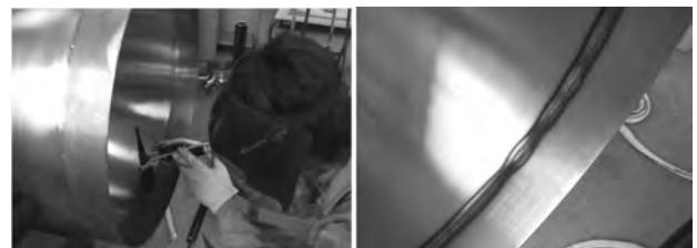
図4 ドーム型モデルのティグ溶接施工とビード外観
